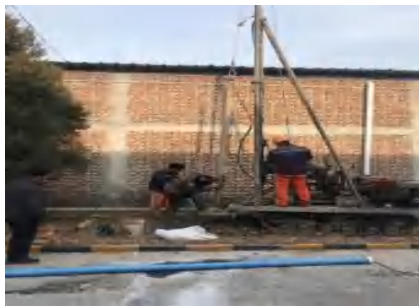
图 9-3 地下水监测井钻孔
